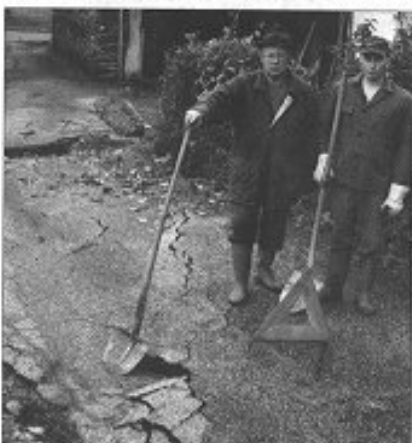
Der „Mühlberg-Bach“ in St. Oswald verwandelte sich zu einem reisenden Gewässer, das die Hauszufahrt zum Bergbauernhof von Leopold und Josef Zainzinger 40 cm unterspülte und den Asphalt wegriss.
